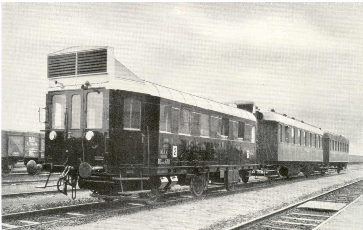
48. ábra. Háromtengelyű szabványos Dieselmotorkocsi két kéttengelyű személykocsival.
