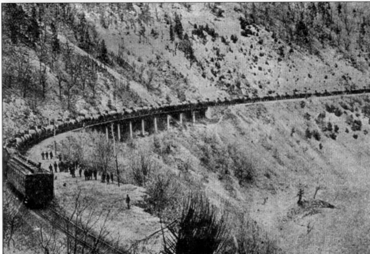
Испытательный поезд весом 110 тыс. пуд. с однопроводным тормозом Казанцева с паровозами на Джарджурском перевале. Закавказская железная дорога
